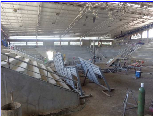
Vista interna del área graderías donde se observa la finalización de las gradas, instalación del barandal metálico de protección y louvers en la fachada norte.
