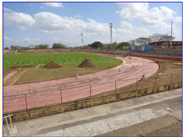
Vista panorámica de la Pista de Atletismo, a la izquierda apreciar la situación sin proyecto y a la derecha observar la actividad de remoción de pista sintética y limpieza del material de pega que quedó en la pista entre la carpeta de rodamiento y la losa de concreto.
