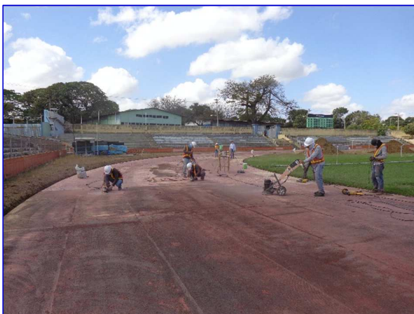
Panorámica de la Pista de Atletismo, durante la ejecución del proyecto. Apreciar los trabajos de remoción de pista sintética y limpieza del material de pega que quedó en la pista entre la carpeta de rodamiento y la losa de concreto, excavación de bordillo de protección de la pista.
