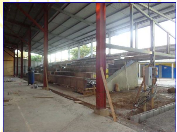
Panorámica de la construcción de las graderías en el costado oeste del Gimnasio de Balonmano.
