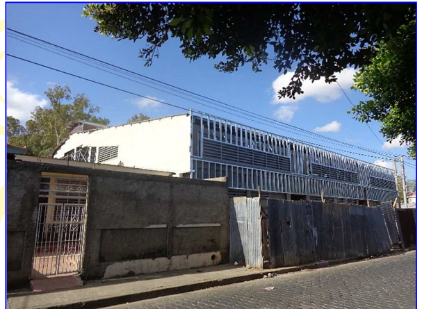
Panorámica costado noreste del Gimnasio de Boxeo, donde se aprecia la instalación de la estructura galvanizada para fachadas e instalación de louvers.
